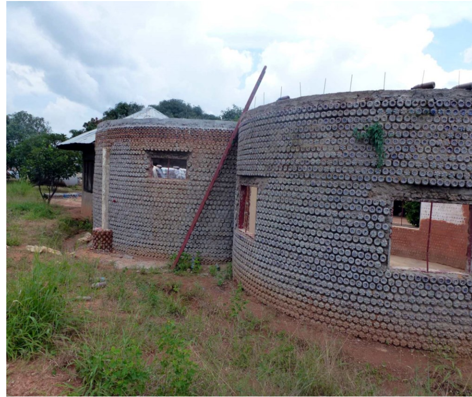
Bild: Lage für Lage werden die Flaschen übereinander geschichtet und miteinander verschnürt. Dabei entsteht eine stabile Wand.
