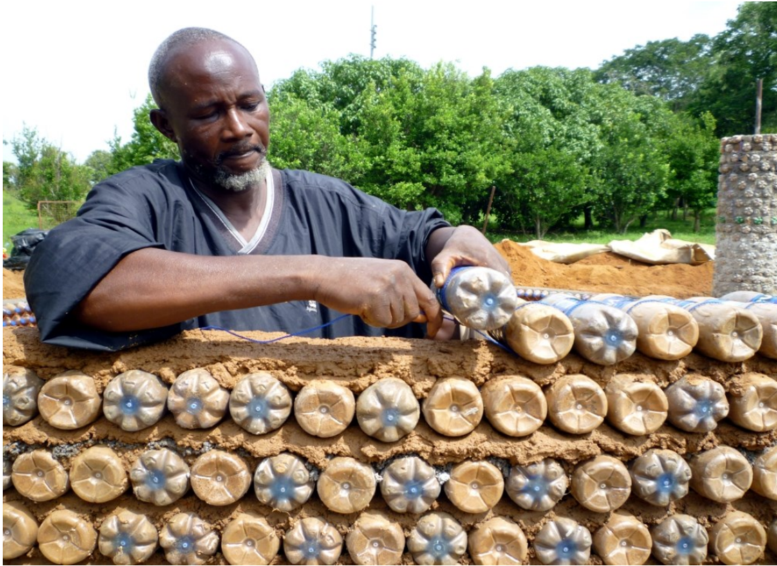
Bild: Lage für Lage werden die Flaschen übereinander geschichtet und miteinander verschnürt. Dabei entsteht eine stabile Wand.
